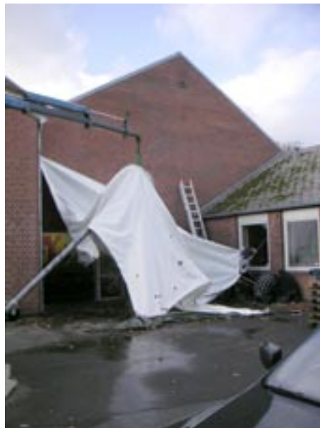
Den nye overdækkede hovedindgang – forhåbentlig er den færdig til jubilæet.
