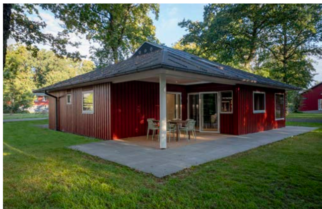
Den nye terrasse
